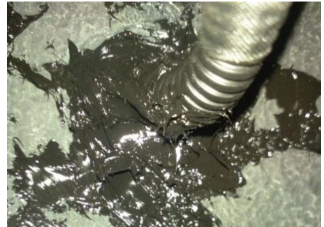
密封穿线孔：如图示意已涂密封胶（图片仅供参考）
